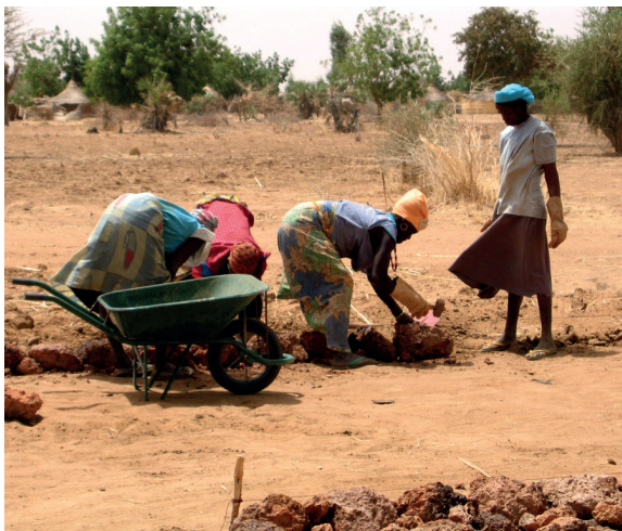
Construction de cordon pierreux d'une piste
