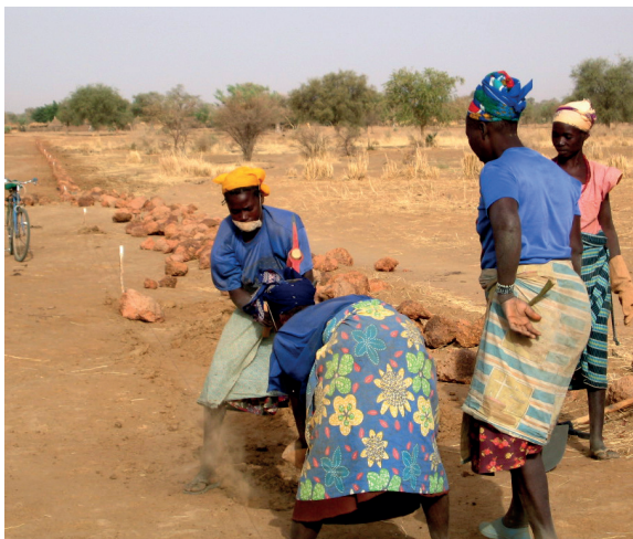
Mise en œuvre de cordons pierreux par des femmes
