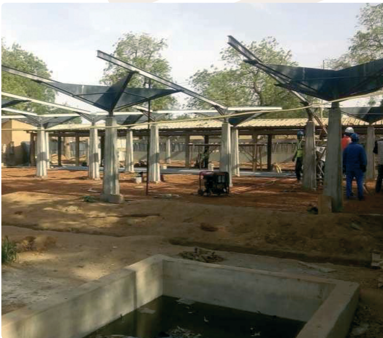
PHOTO : LES ÉTUDES N'ONT DE SENS QUE SI ELLES DÉBOUCHENT SUR DES CONCRÉTISATIONS (CHANTIER DU MARCHÉ DE TÉRA 2019).
